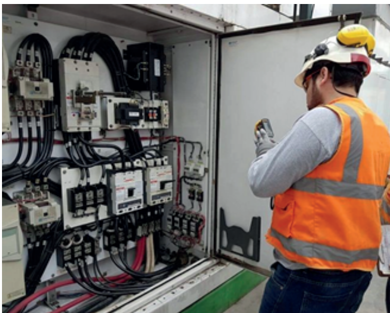
Imagen 15: Revisión a un tablero eléctrico de distribución.
