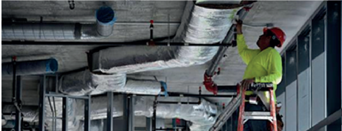
Imagen 10: Instalación de ductos de aire acondicionado.
